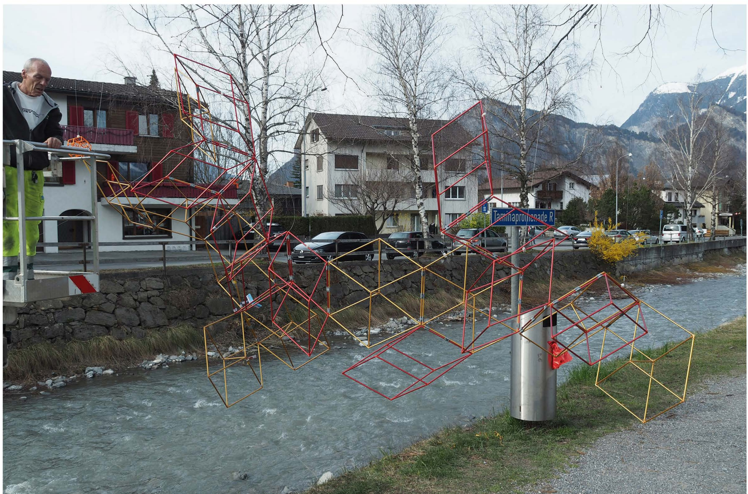
installation von «hündchen2» an der taminapromenade R in bad ragaz, unmittelbar bevor diese über die tamina geschoben wird.
